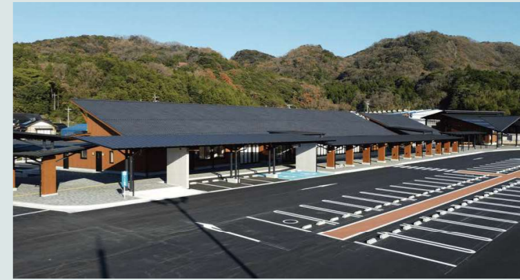
道の駅ごいせ仁摩 竣工
