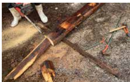
古材の洗浄と釘抜
