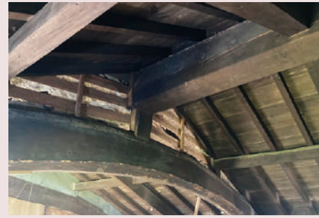
大断面のクロマツ材による梁・桁
